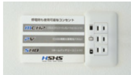
災害時はコージェネ、ソーラー、ホームバッテリーで電力を自給。規格が定まった後には、すべてのコンセントから需給バランスを見てシームレスにつなげます
