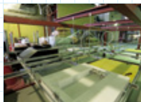
天井に負担をかけないように導入された鋼材
