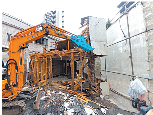
建物解体中の作業風景
