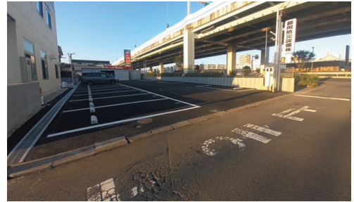
駐車場工事完成風景
