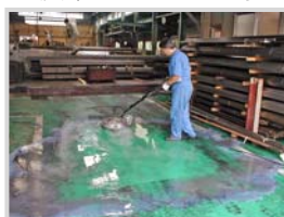
●床面の脱脂洗浄
